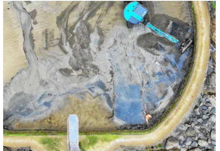
Vue d'un drone, la pelle au travail de dessablage dans la piscine.
